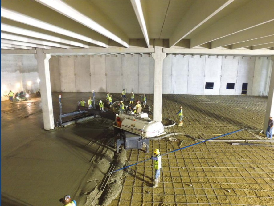
Pouring warehouse floor
